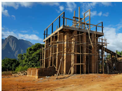
Energieeffiziente Ziegelherstellung in Malawi
